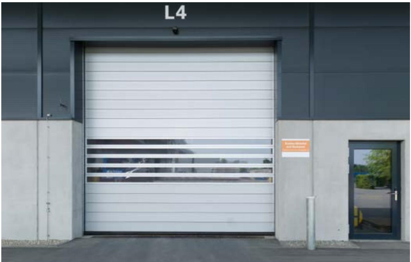
rührungsfrei und damit verschleißfrei sowie geräuscharm aneinander vorbeigeführt werden können. Bei schwerster industrieller Belastung absolvieren die EFA-SST® mühelos bis zu 200.000 Öffnungszyklen pro Jahr. Zusätzlich sind die Tore mit jeweils fünf doppelwandigen, thermisch getrennten Alusichtlamellen versehen. „Das erhöht die Verkehrssicherheit vor den Toren und bringt mehr Tageslicht in die Halle“, erklärt Georg Beck.
