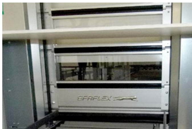
Vier Schnelllauf-Spiraltore vom Typ EFA-STT® mit geringerer Durchlasshöhe kommen am AutoStore-Zugang im 3. Obergeschoss zum Zuge
